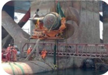
CAMBIO DE THRUSTER DE TUNEL
